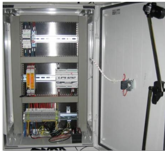
Fotografía interior cuadro con M100
